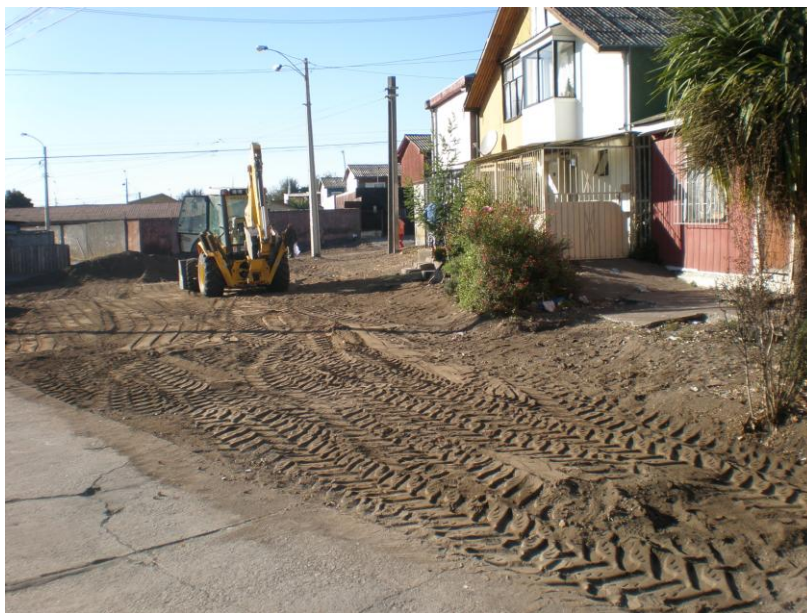
Construcción de Area Verde ubicada en Yugoslavia esquina Viena.
